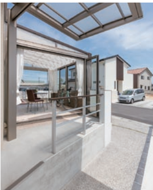
車を降りてからスロープを上り、ガーデンルームへ。カーポートの梁を建物までのばし、屋根を設けたので、雨でも濡れずに出入りできます。
