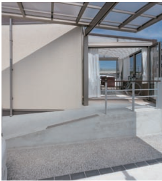
車を降りてからスロープを上り、ガーデンルームへ。カーポートの梁を建物までのばし、屋根を設けたので、雨でも濡れずに出入りできます。
